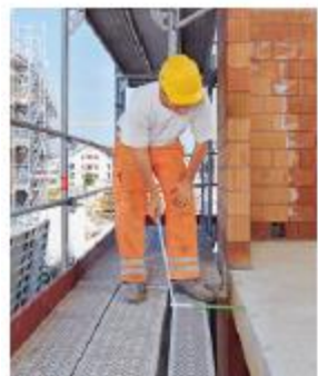
Règle 5 Contrôler les échafaudages.
