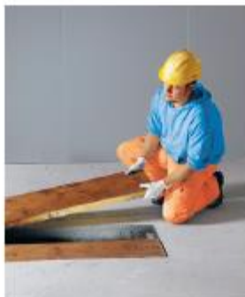
Règle 2 Sécuriser les ouvertures dans les sols.
