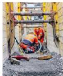
Règle 8 Sécuriser les fouilles et les terrassements.
