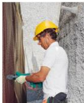
Règle 8 Sécuriser les fouilles et les terrassements.
