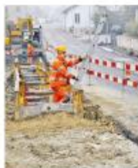
Règle 7 Installer des accès sûrs.
