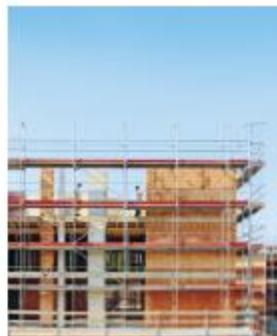
Règle 4 Travailler avec un échafaudage de façade.
