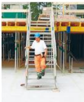
Règle 6 Installer des accès sûrs.
