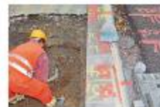
2 Effectuer des sondages dans le terrain.
