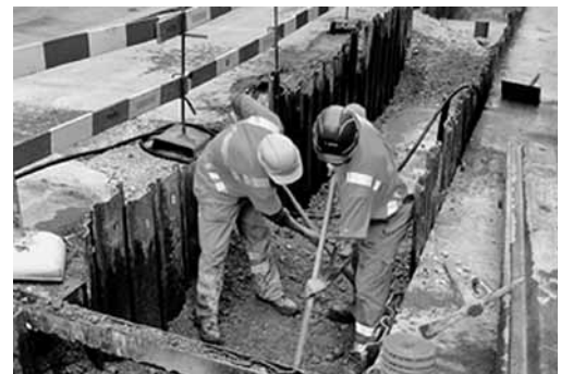
Figure 2: les travaux très pénibles sont à effectuer tôt le matin.
